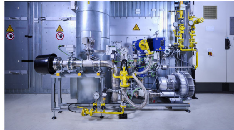
Abb.: Wasserstoffbrenner in der Lackiererei
