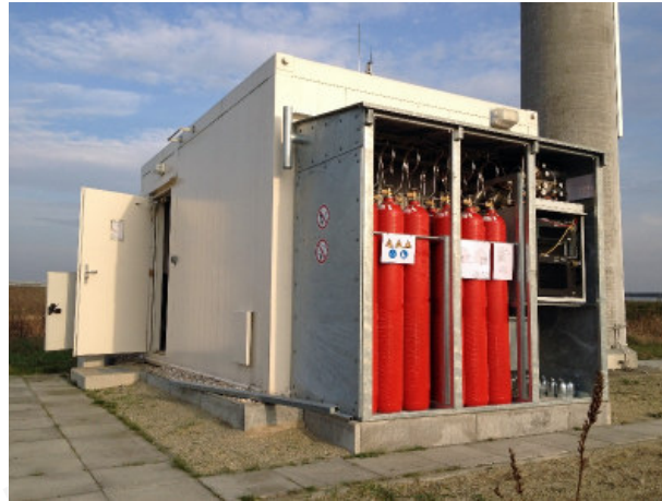
BDBOS- Basisstation mit Brennstoffzellensystem als Notstromversorgung
